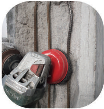
а) очищення арматурних стрижнів від корозії за допомогою електроінструменту
