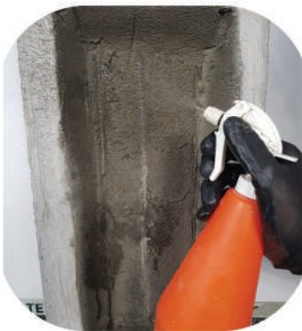
а) зволоження поверхні перед нанесенням ремонтних сумішей
