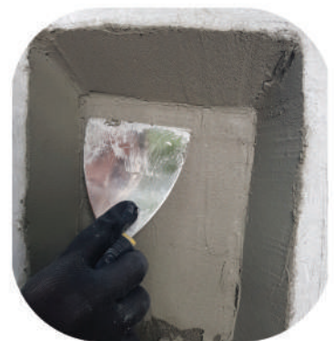
в) нанесення другого шару ремонтної суміші (за потреби)
