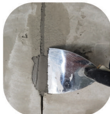
в) заповнення тріщини ремонтною сумішшю
