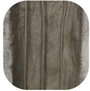
в) підготовлена поверхня для нанесення ремонтних сумішей
