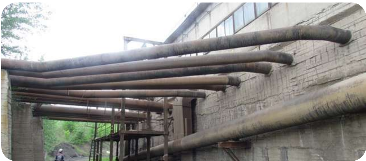
Рис. 3. Пошкодження захисного шару бетону залізобетонних панелей
