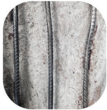
в) стан підготовлених арматурних стрижнів
