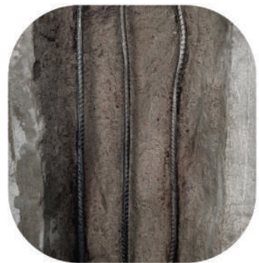
в) підготовлена поверхня для нанесення контактної суміші
