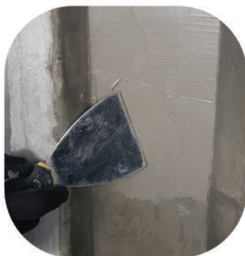
б) нанесення ремонтної шпаклівки
