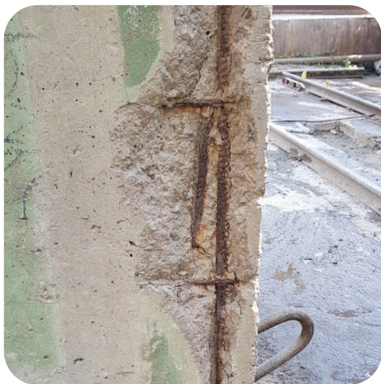
Рис. 1, 2. Пошкодження захисного шару бетону та оголенням арматури залізобетонної колони
