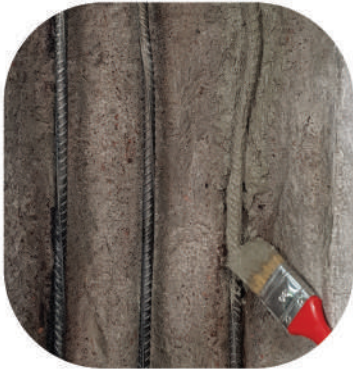
а) нанесення контактної суміші на арматурні стрижні
