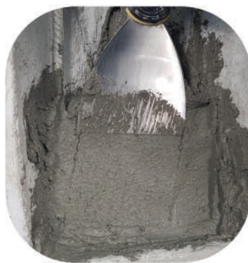
б) нанесення першого шару ремонтної суміші
