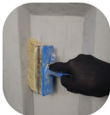
а) очищення поверхні від пилу та бруду
