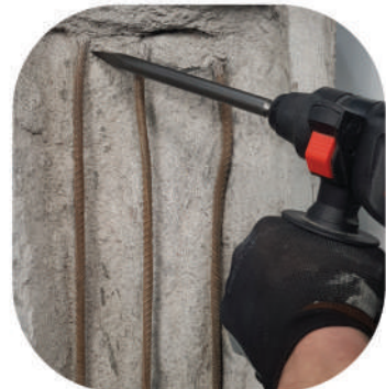
в) видалення неміцних ділянок бетону електроінструментом
