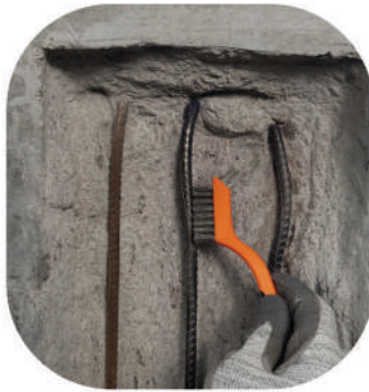
б) очищення арматурних стрижнів від корозії за допомогою ручного інструмента
