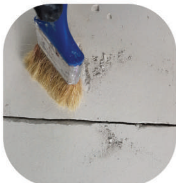
а) очищення поверхні від пилу та бруду
