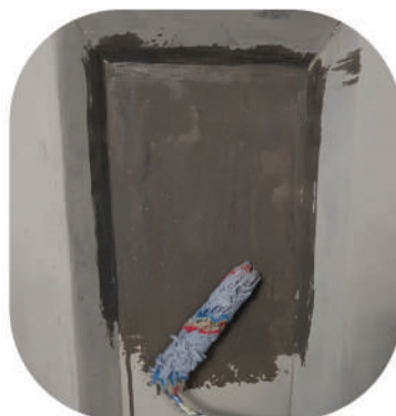
б) оброблення поверхні ґрунтовкою
