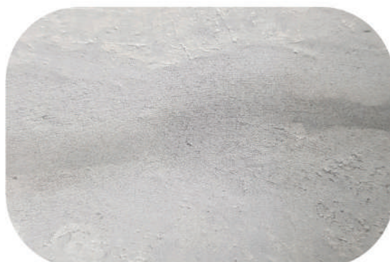
д) вигляд відремонтованої поверхні
