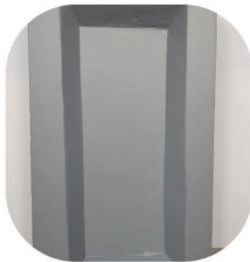
д) вигляд відремонтованої ділянки залізобетонної конструкції
