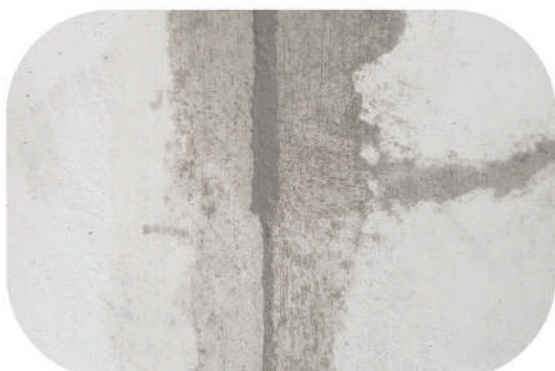
г) заповнення тріщини ремонтною сумішшю
