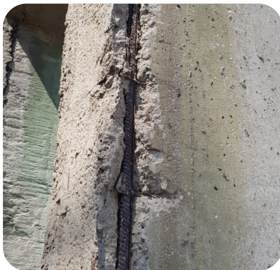
Рис. 1, 2. Пошкодження захисного шару бетону та оголенням арматури залізобетонної колони
