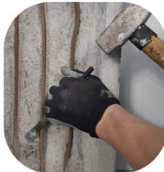
б) видалення неміцних ділянок бетону ручним інструментом
