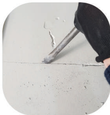
Рис. 11. Розшивка тріщин ручним або електроінструментом
