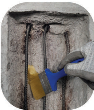
а) очищення поверхні від пилу та бруду
