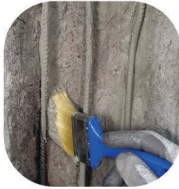
б) нанесення контактної суміші на поверхню бетону
