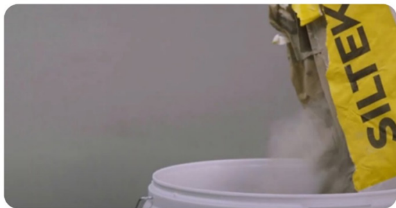
Рис. 4–5. Приготування розчину.
