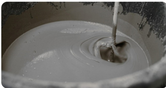
Рис. 4–5. Приготування розчину.
