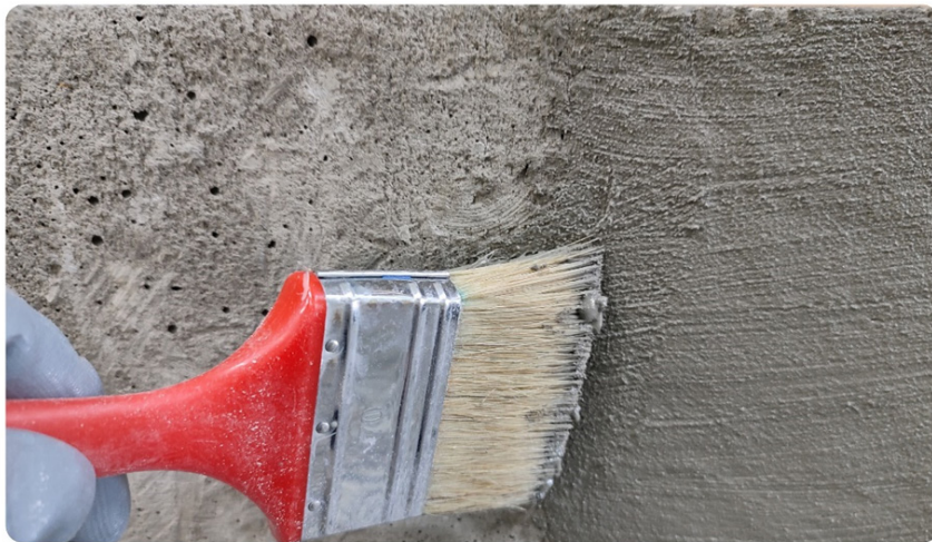
Рис. 12. Нанесення проникної гідроізоляції Siltek VP-35.
