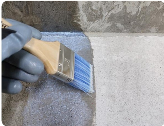
Рис. 14–15. Очищення та обробка поверхні ґрунтовкою Siltek Universal E-100.
