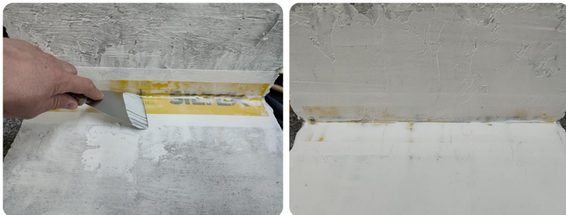
Рис. 18–19. Приклеювання гідроізоляційної стрічки та нанесення другого шару гідроізоляції Siltek Prooflex.
