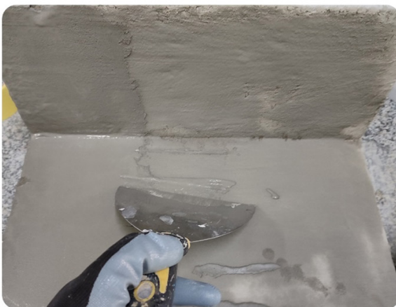
Рис. 6–7. Нанесення першого та другого шарів гідроізоляції.
