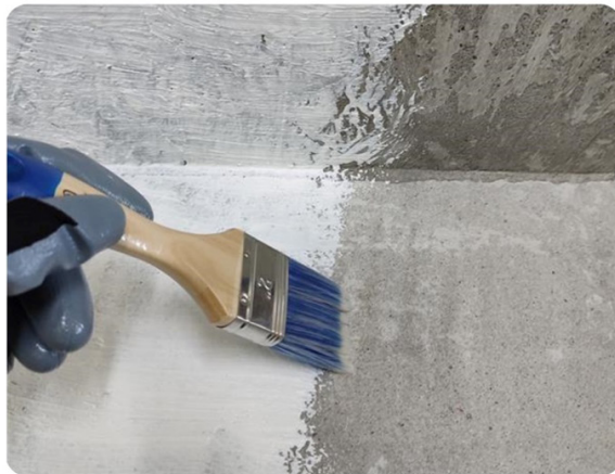
Рис. 16–17. Нанесення першого шару гідроізоляції Siltek Prooflex.
