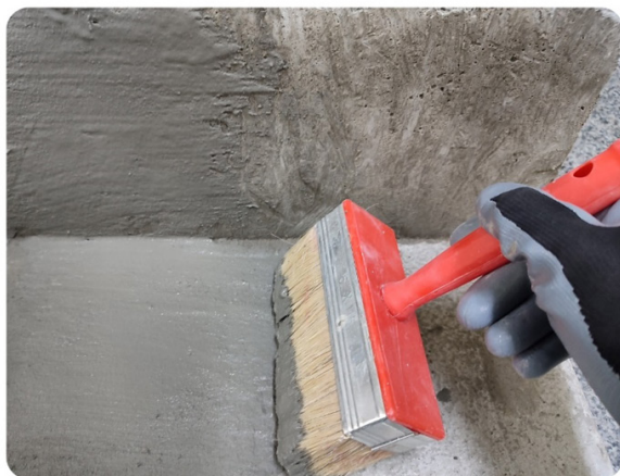
Рис. 6–7. Нанесення першого та другого шарів гідроізоляції.
