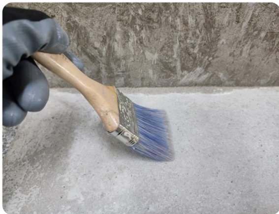
Рис. 2. Очищення поверхні.
