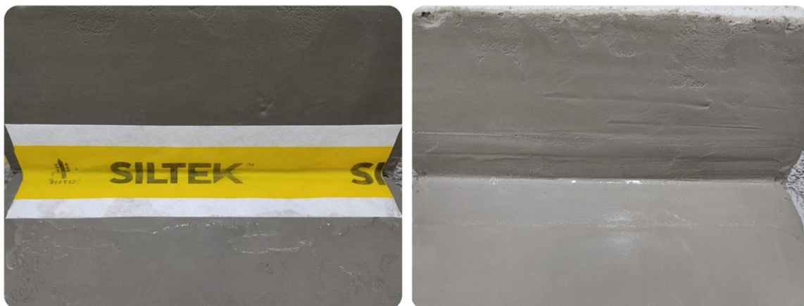
Рис. 8–9. Приклеювання гідроізоляційної стрічки.
