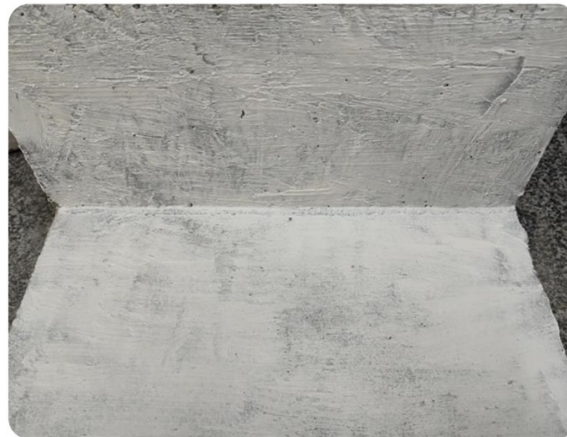
Рис. 16–17. Нанесення першого шару гідроізоляції Siltek Prooflex.
