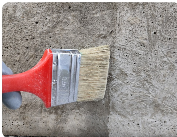
Рис. 11. Зволоження поверхні.
