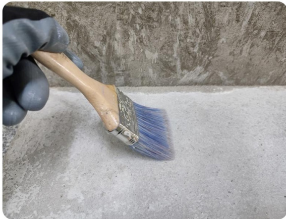
Рис. 14–15. Очищення та обробка поверхні ґрунтовкою Siltek Universal E-100.
