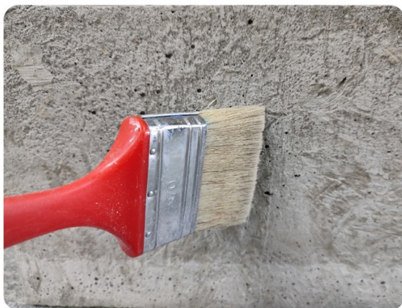
Рис. 10. Очищення поверхні
