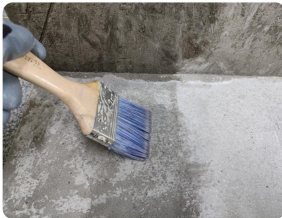
Рис. 3. Зволоження поверхні.
