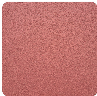
в) вигляд відремонтованої ділянки
