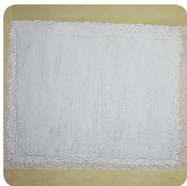
а) обклеювання контуру пошкодження малярною стрічкою
